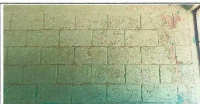
Foto 5: Repello o cernido de paredes
